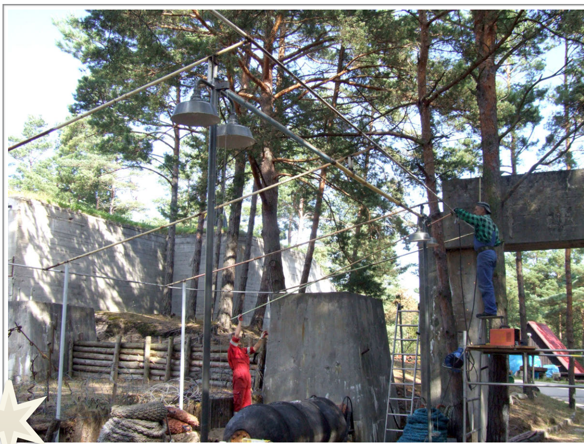
Po zakończeniu sezonu turystycznego wykonujemy prace, które w sezonie utrudniałyby zwiedzanie. Na zdjęciu: montaż konstrukcji dachu nad sceną, a jednocześnie widownią Kina Letniego.
