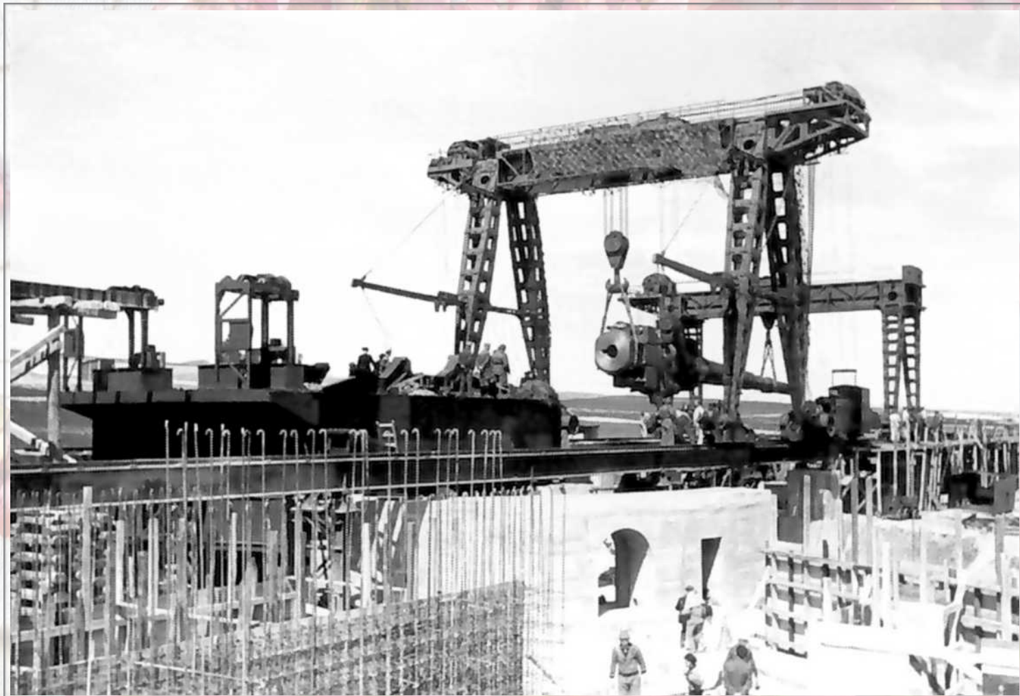
Stanowisko baterii Lindemann we Francji – suwnica montażowa w trakcie montażu wążcej 160 ton lufy
