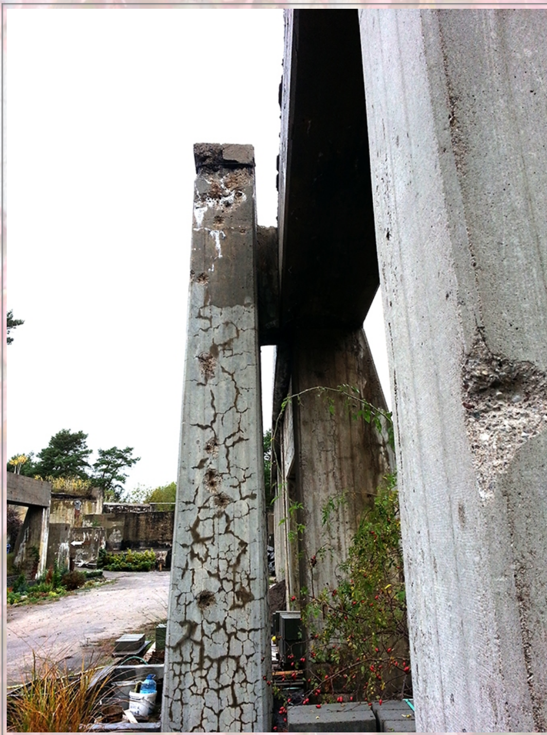
Stanowisko B1 wspornik poprzeczny
