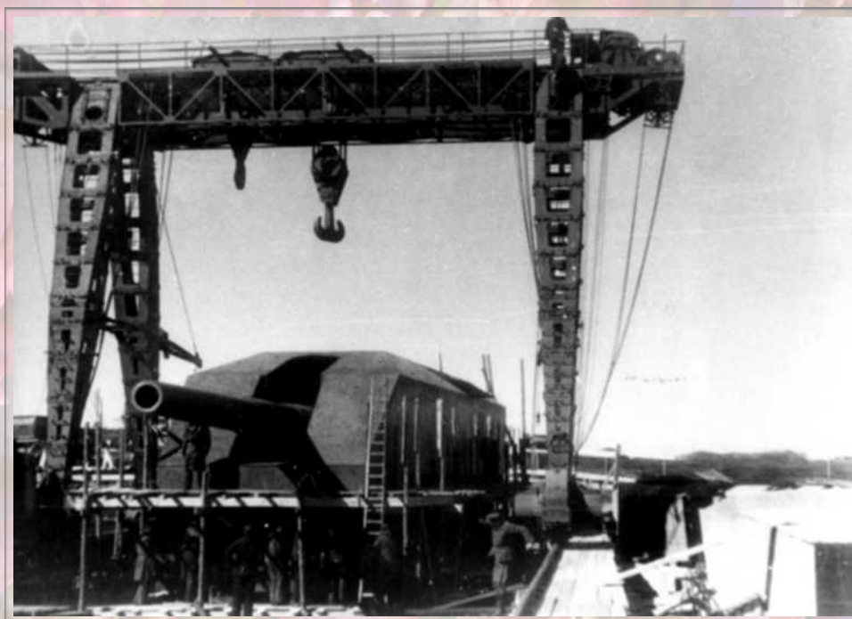
Suwnica nad zmontowanym działem 406mm
